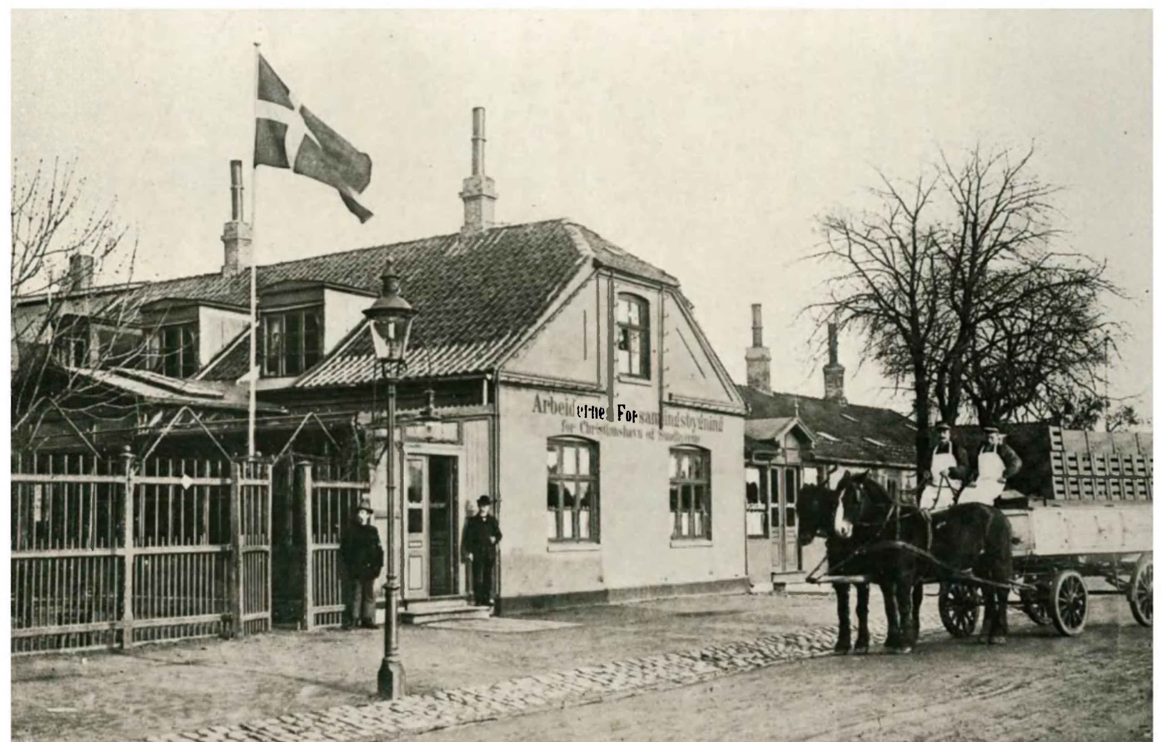
Arbejdernes Forsamlingsbygning på Kløvermarksvej 3, ca. 1898.
